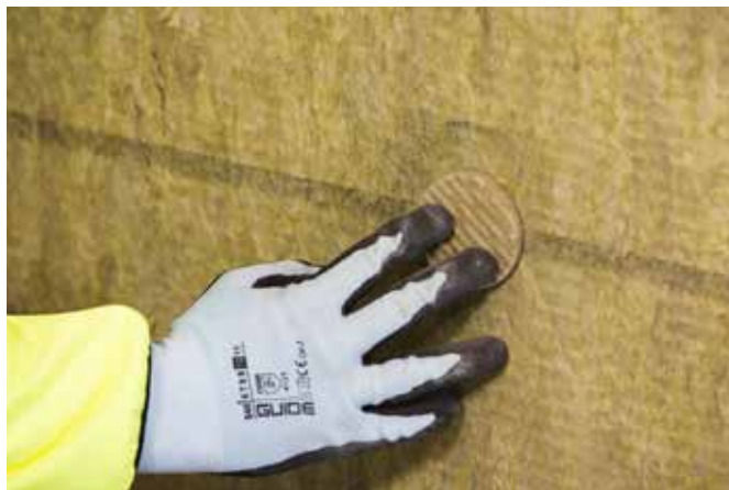
Trykk på plass pluggisolasjon.
