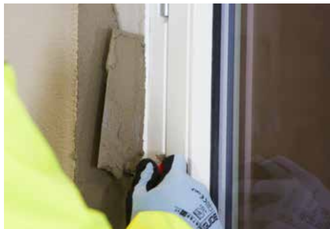
Innpussing av Mapetherm Corner Profile .
