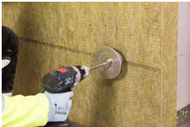
Benytt Mapetherm Tool for fiksering av plugg.
