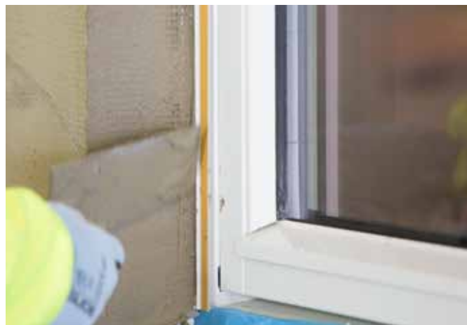
Innpussing av Mapetherm Profil W .
