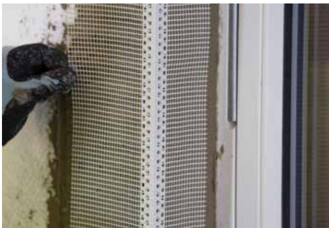
Plassering av Mapetherm Corner Profile ved vindussmyg.
