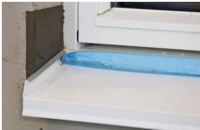
Sålbenkbeslag montert.
