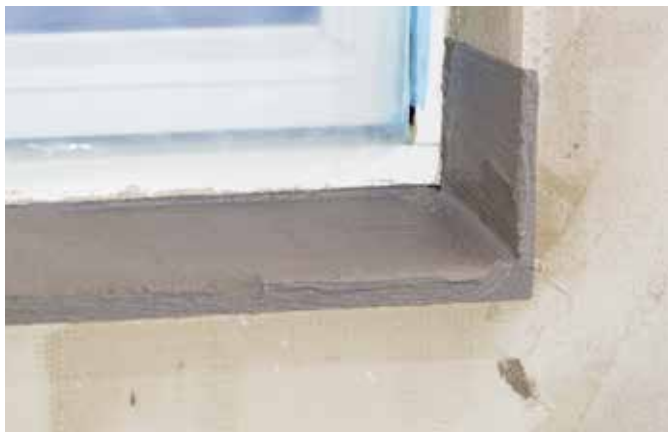
Mapelastic påført ved sålebank.
