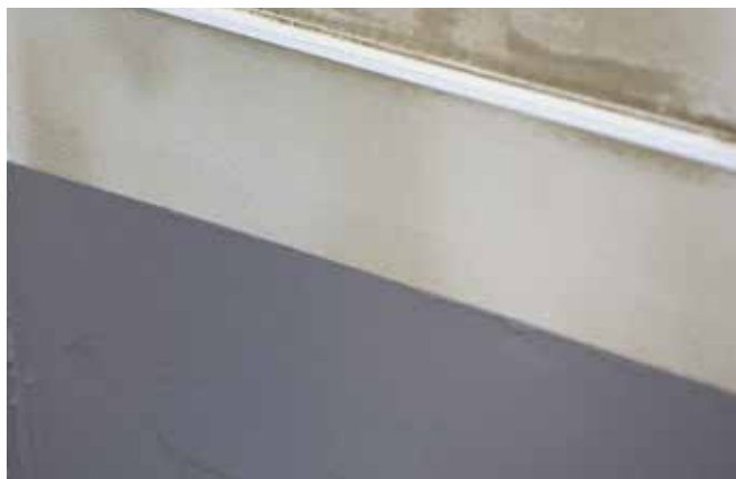
Mapelastic påført i sokkelområde.
