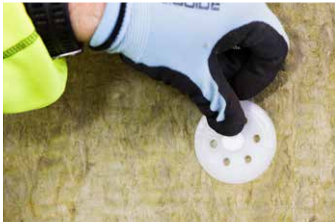
Benytt Mapetherm Tool for fiksering av plugg.
