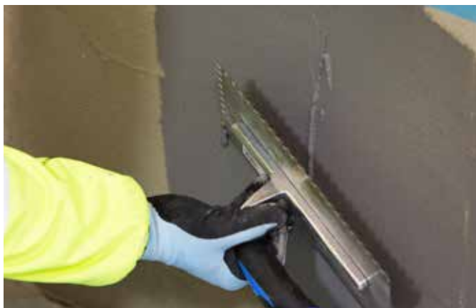
Påføring av Mapelastic .
