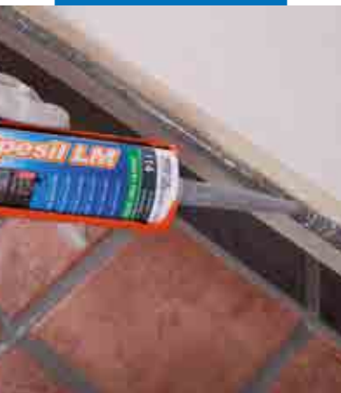
Fuging av fliser innendørs
