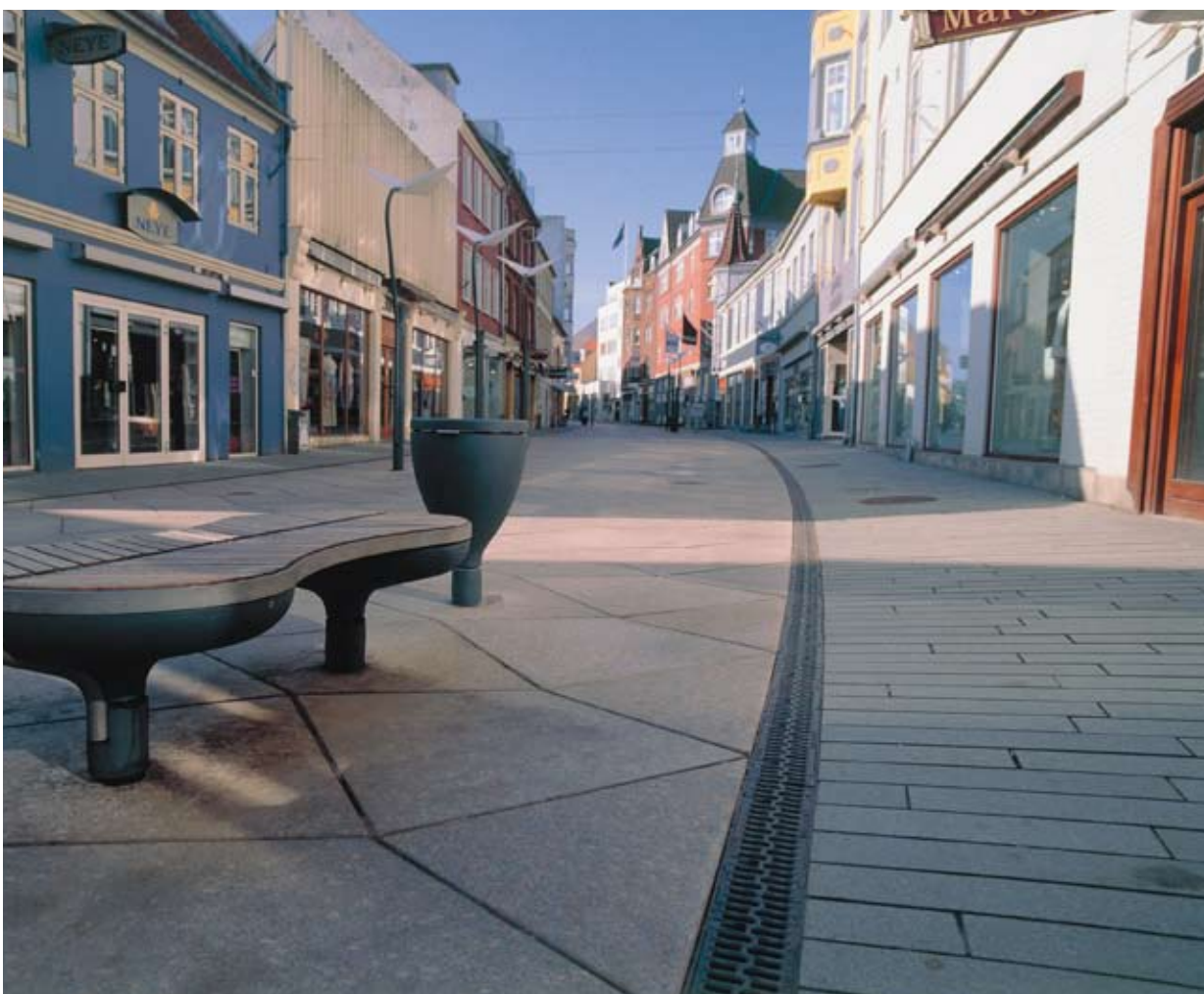
ACO DRAIN® S 100 K Gågaten i Vejle
