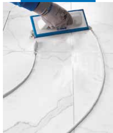
Fuging av porselen fliser med Ultracolor Plus
