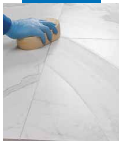
Rengjøring og sluttbehandling av fugene med hard cellulose svamp
