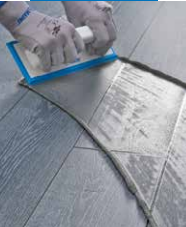
Fuging av Ultracolor Plus på fliser med trestruktur med gummibrett
