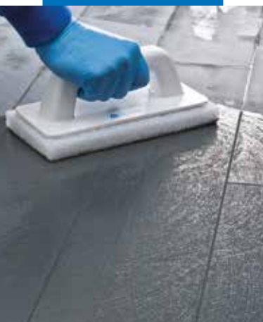
Vasking av fuger med Scotch-Brite® skurepute (produkt delvis herdet)
