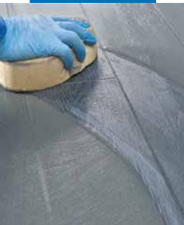
Vasking av fuger med svamp
