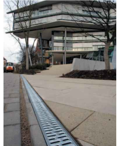
ACO DRAIN® Multiline® ved innkjøringen til et parkeringsområde.
