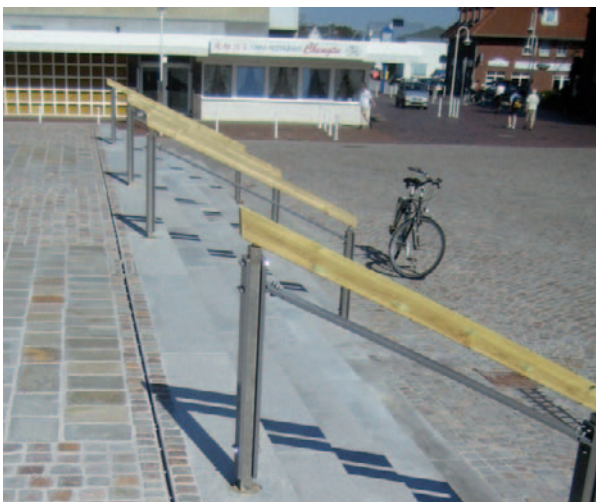
Overflatedreining, diskre og elegant. ACO DRAIN® Multiline® med slisseramme.
