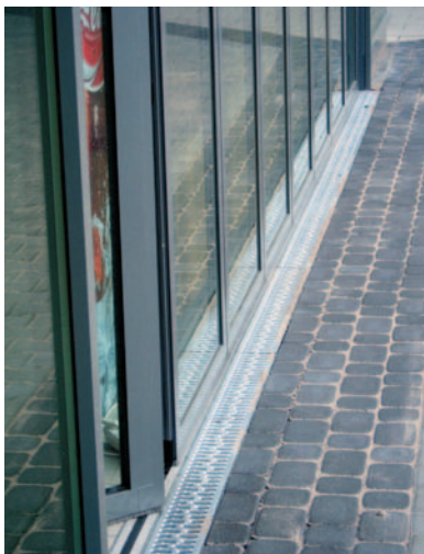
ACO DRAIN® Multiline® til avvanning av fasader
