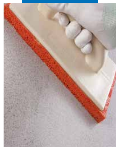
Pusslaget sluttbehandles med svampebrett
