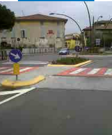
Eksempel på fartsdamp med fotgjengerfelt
