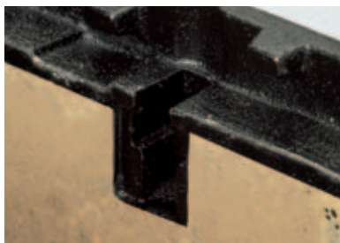
Låsetapper som forskyvningssikring
