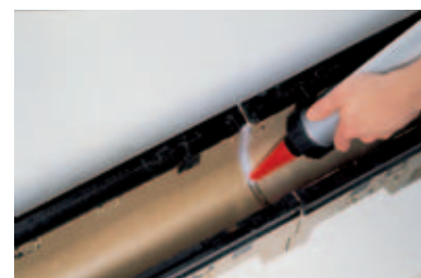
Utfuging av sikkerhetsfalsen med ACO fugemasse.
