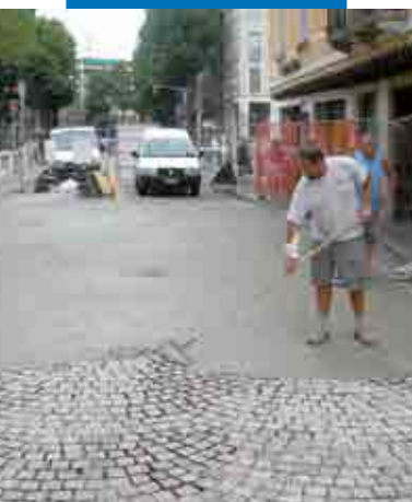
Fordel fugemassen på den våte underlaget
