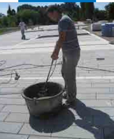
Miks Mapestone PFS 2 vertikal blander, drill eller i en bølge med en miksespiral
